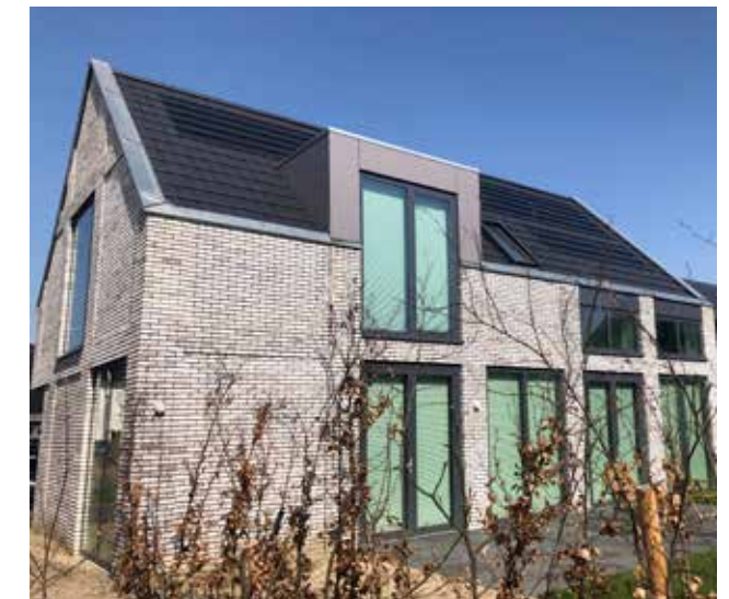
De PV-modules volgen de horizontale belijning van de dakpannen.
