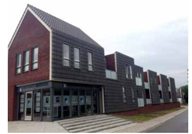
Om het dak vloeiend over te laten lopen in de gevel, heeft Nelskamp Dakpannen de zogenaamde knikpan ontwikkeld.
