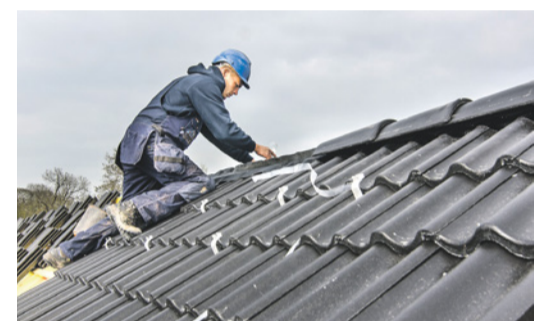
De lichtgewicht betonpan is in een compleet leveringsprogramma te verkrijgen, waarbij ook de gevelpannen licht van gewicht zijn.
