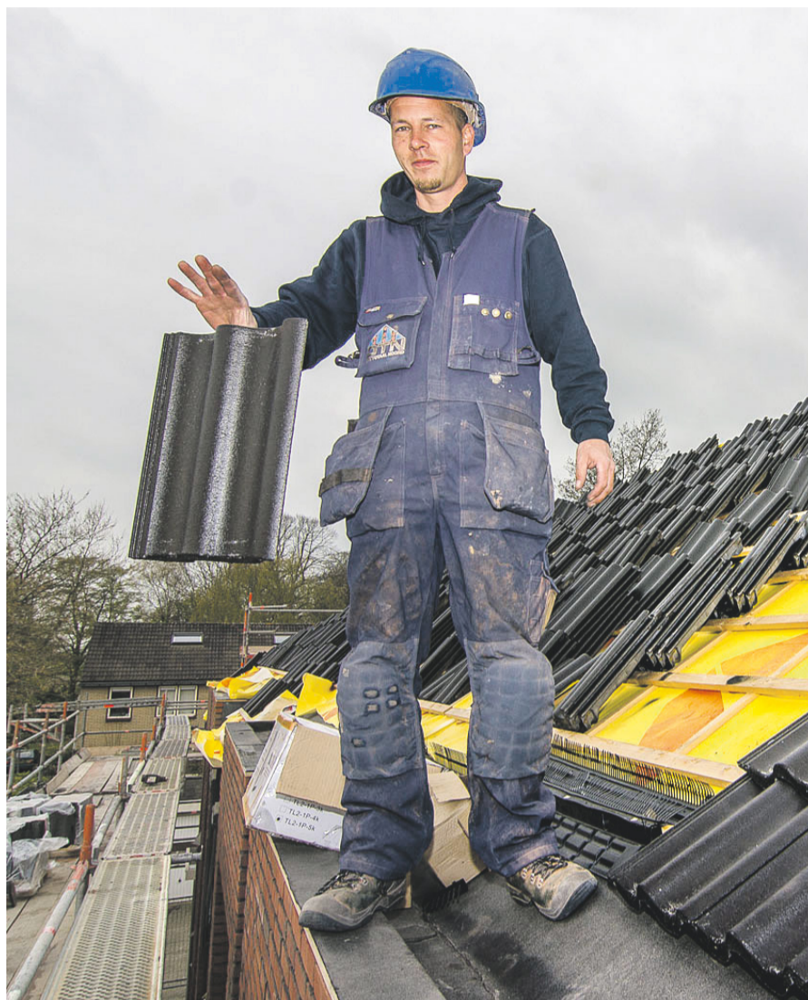
De EasyLife betonpan met een gewicht van 3 kg is 30% lichter dan standaard dakpannen en dat biedt fysieke voordelen voor de verwerkers.
