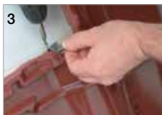
3 van bovenaf in de panlat schroeven.
