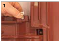
1 De Multi klikhaak wordt over de kopsluiting gezet...
