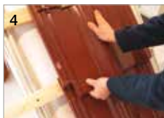
4 De volgende dakpan indekken en aandrukken. Klaar!
